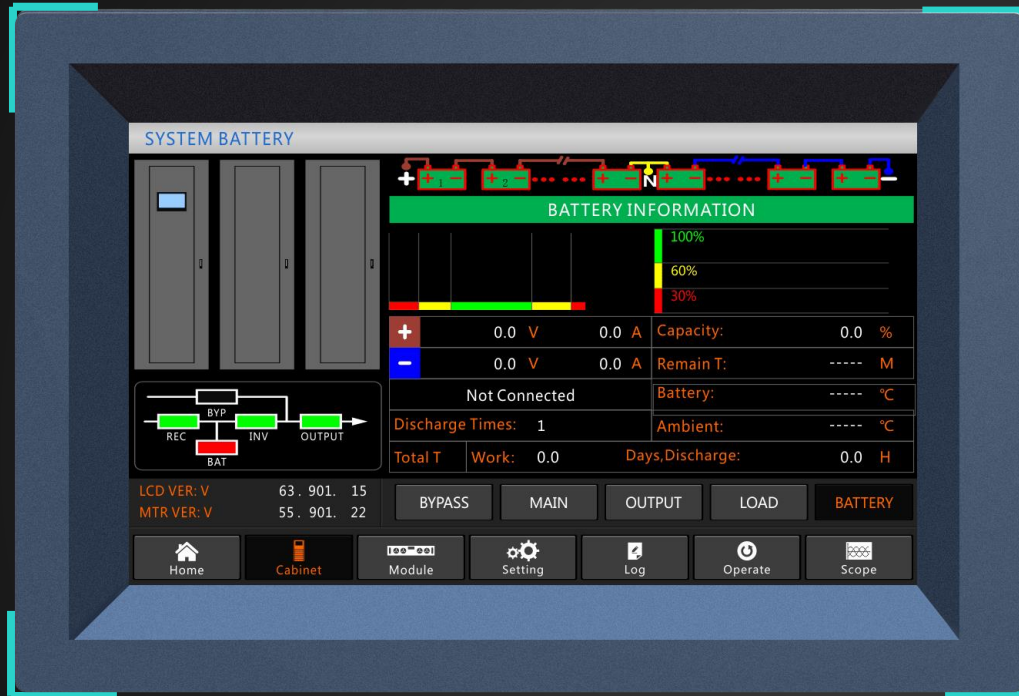
Schermata informazioni sullo stato delle batterie
