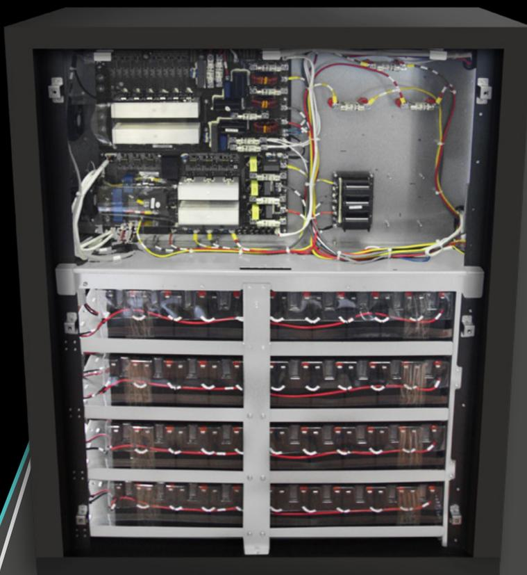
L'innovativo cabinet di NOVA integra al suo interno un'apposita parete metallica che separa nettamente la sezione elettronica dall'area delle batterie.
